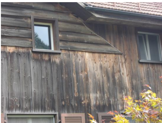
Fledermausquartier unter der Holzfassade
